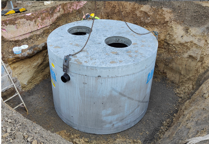
friwa Kompaktanlage (Schlammfang und Mineralölabscheider)
