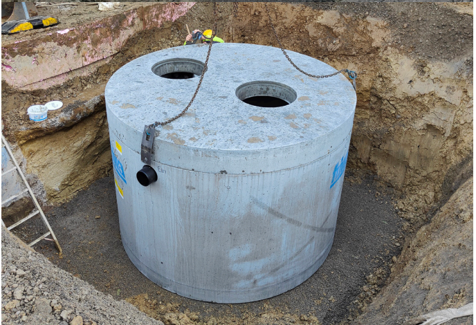
friwa Kompaktanlage (Schlammfang und Mineralölabscheider)
